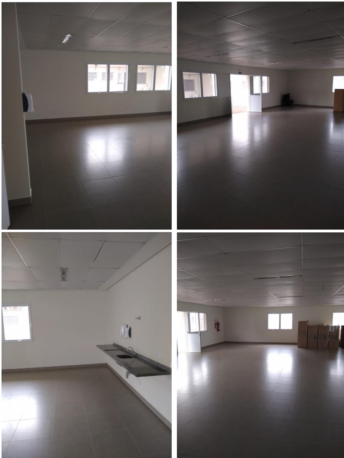
Área entre a UTI e ENFERMARIA, com lavatório e amplo espaço. Ideal para prática do alongamento laboral.
